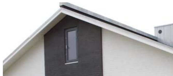
Loftslemmen er placeret i gavlen for ikke at gennembryde det lufttætte lag. En loftslem øger infiltrationen unødigt, da lukkemekanismen er vanskelig at gøre helt tæt.
