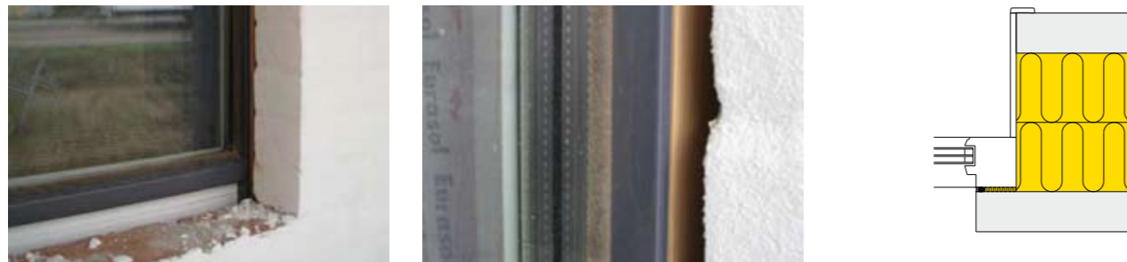
Det er muligt at mure hen foran de tyske vinduer, da de åbner indad. Dette er med til at minimere kuldebroen. Gummifugen sikrer, at der ikke løber vand ind bag vinduet og ind i hulmuren.
