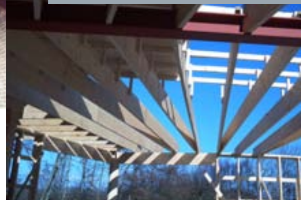
Spær til store spændvidder
